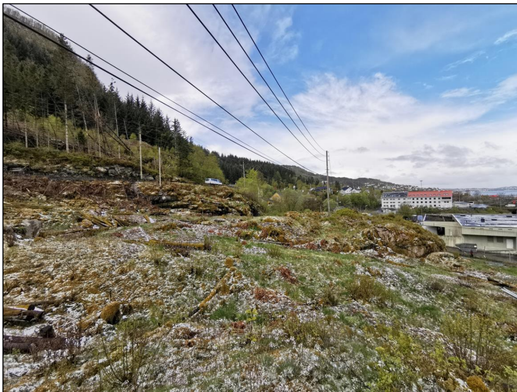
Figur 5-2: Foto av påhuggs-/forskjæringsområdet for hovedløpene i Eidsvåg. Bildet er tatt mot vest. En kan tydelig se bergkoller nær overflaten, med mellomliggende søkk.
